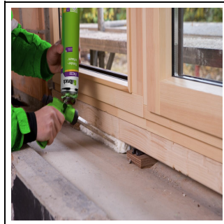
2. Bild: Verarbeitung der Fensteranschlussfuge mit FM220.
